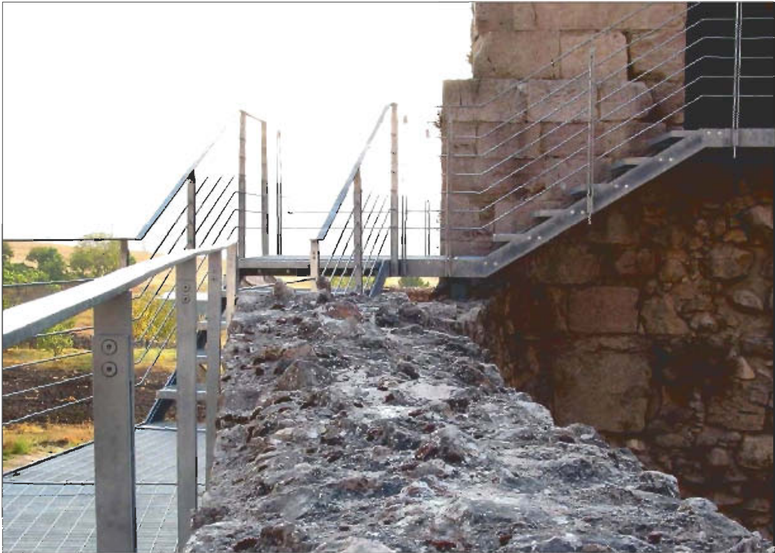
Accesso alla Torre Febronia
